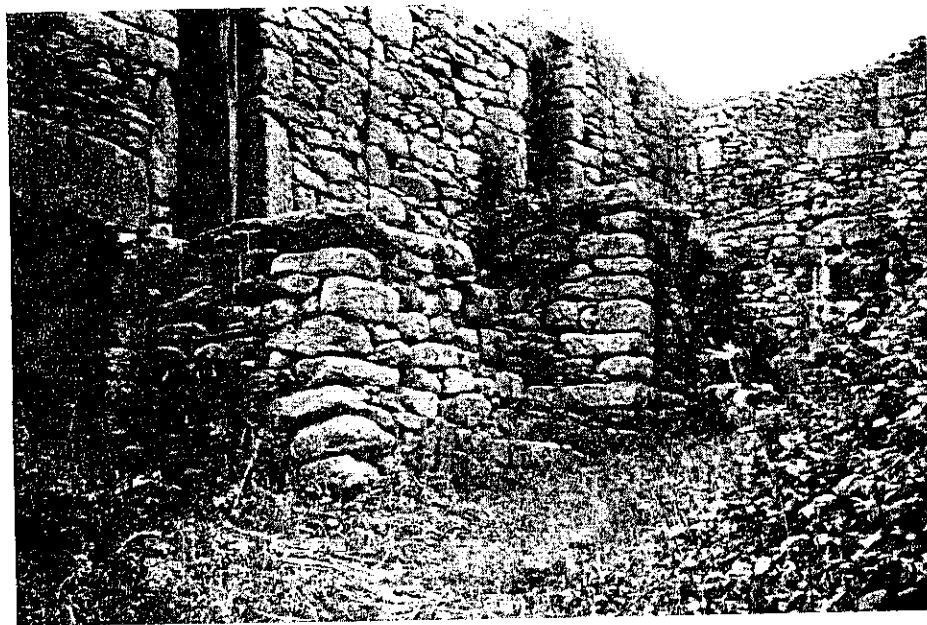
Fig. 12 — Pormenor das escadas de acesso ao 1.º andar.
